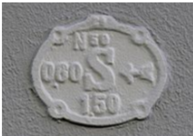
Historisches Hinweisschild (Wasserschieber)
