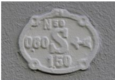
Historisches Hinweisschild (Wasserschieber)
