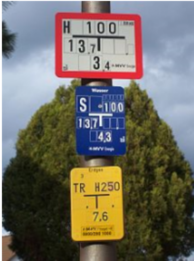
Hinweisschilder für Hydrant, Wasserschieber und Erdgas
