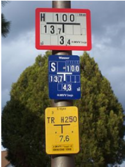
Hinweisschilder für Hydrant, Wasserschieber und Erdgas
