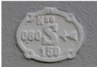
Hinweisschilder zu Straßeneinbauten weisen auf (Straßenkappen von) Straßeneinbauten wie Unterflurhydranten oder Absperrschieber von Wasserversorgungs-, Abwasserentsorgungs-, Gas-, Fernwärme- und Energieversorgungsunternehmen hin.
