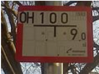
Hinweis auf einen Überflurhydranten (OH) sowie den Betreiber (rechts unten Mainova)
