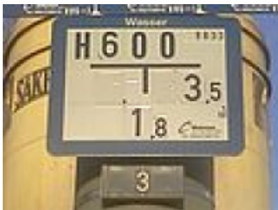
Blaues Hydrantenschild zum Hinweis, dass dieser Hydrant zusätzlich Be- und/oder Entlüftungseinrichtungen für die Leitungswartung besitzt
