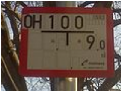
Hinweis auf einen Oberflurhydranten (OH) sowie den Betreiber (rechts unten Mainova)
